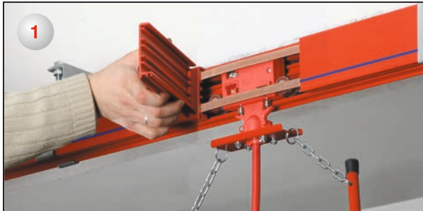
1 Раскрутите болты, скрепляющие соединительный элемент.
